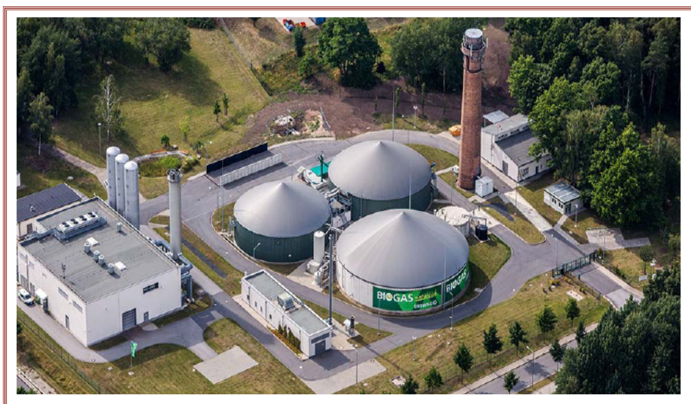
Biogazownia Dresden-Klotzsche (Źródło: SachsenEnergie)
