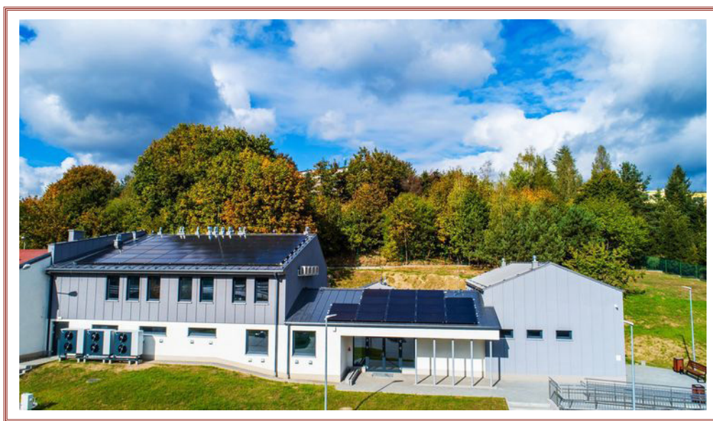
Panele fotowoltaiczne zamontowane na dachu budynku Schroniska dla Zwierząt (Źródło: Bydgoszcz.pl)
