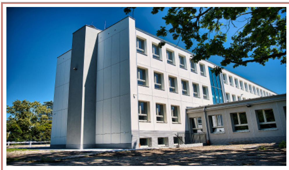
Elewacja z boku budynku VII LO (fot. Błażej Witkowski)
