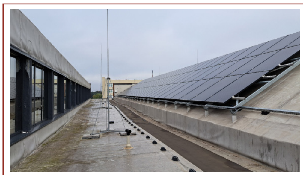
Panele fotowoltaiczne zamontowane na dachu budynku Astorii (Źródło: PNEC)
